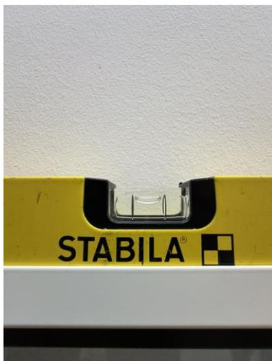
5. On ajuste la verticalité par un niveau à bulle d'air et on visse le box sur les consoles.
