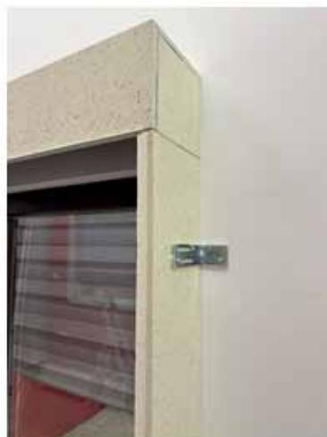
Comme alternative, on propose l'enveloppe SIO qui n'est produit qu'en polystyrène avec une douille pour la coulisse. Le montage se fait sous forme d'application d'une à mousse sur le fond préparé.
